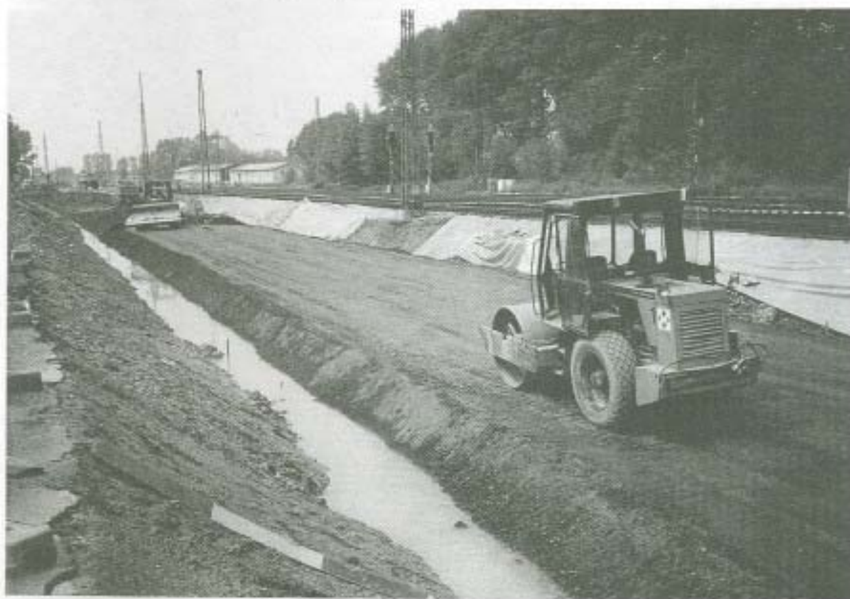
Abb. 2: Einsatz von Immobilisat als Dammbaustoff im Eisenbahnbau
