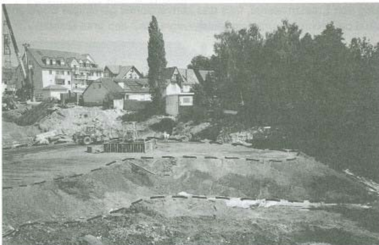
Abb. 3: Gründungsschicht für eine Wohnbebauung aus immobilisiertem Bodenmaterial (unterbrochene Linie)
