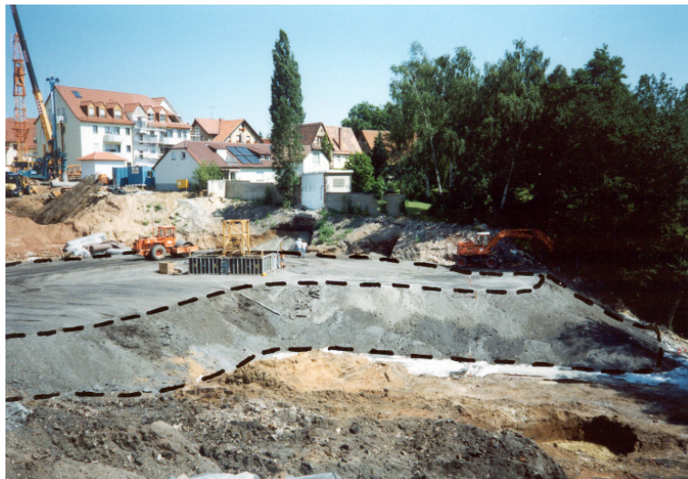
Abb. 2 Immobilisat als Fundationschicht im Hochbau
