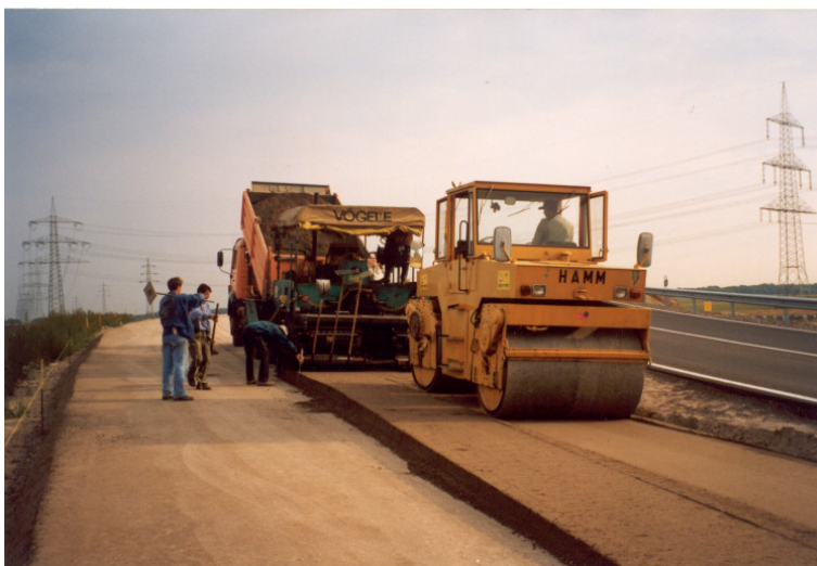
Abb. 3 Einbau von Immobilisat als hochwertige HGT im Straßenbau
