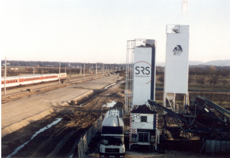
Abb. 1 Herstellung des Dammes für die ICE-Trasse Karlsruhe-Basel aus Immobilisat
